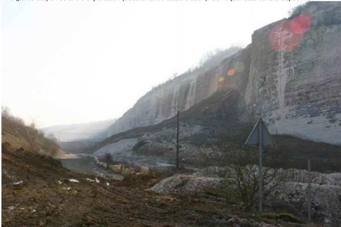
Photographie 1 : Eboulement massif du front de taille survenu en 2001 – partie Est de la carrière
